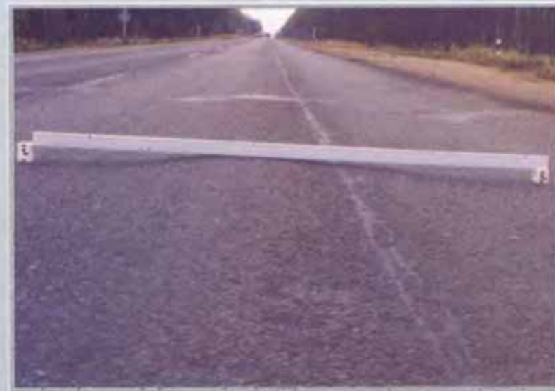
Рис. 6.13. Колейность менее 15 мм
