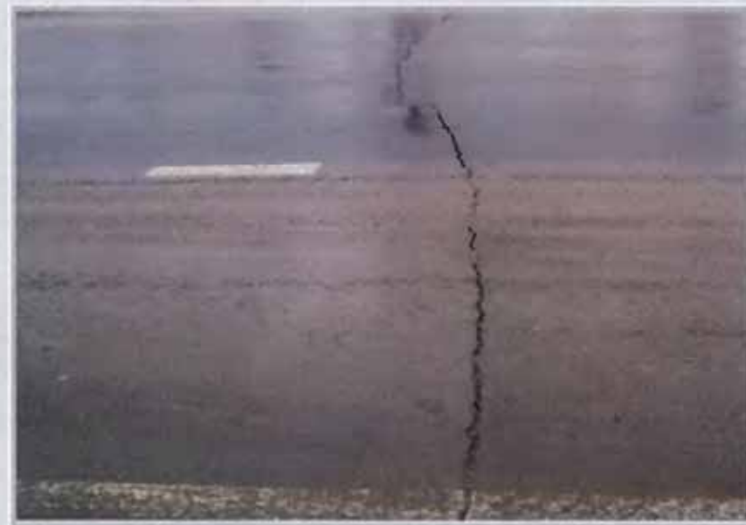
Рис. 6.3. Отдельная трещина
