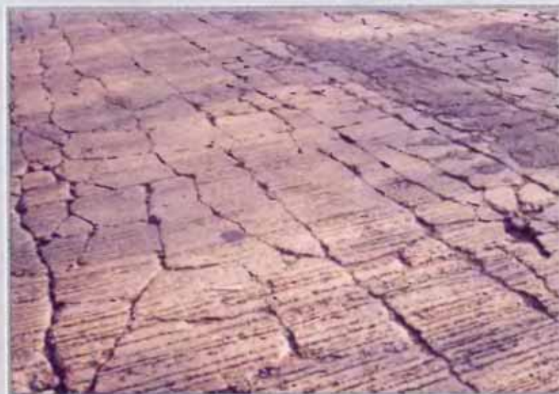
Рис. 6.25. Разрушение плит
