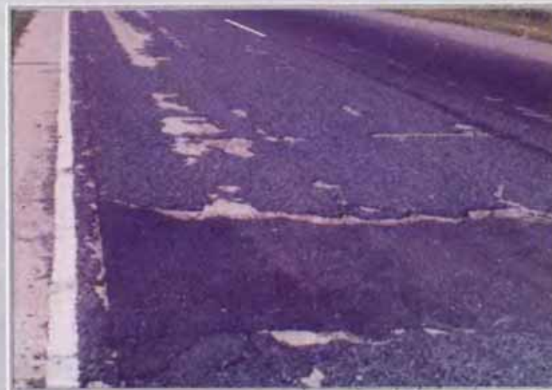
Рис. 6.26. Выкрашивание поверхностной обработки
