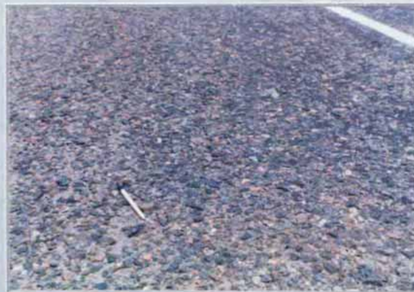
Рис. 6.16. Шелушение покрытия
