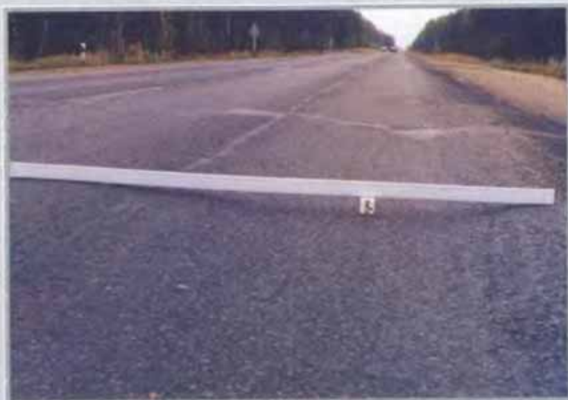
Рис. 6.14. Колейность от 15 до 30 мм
