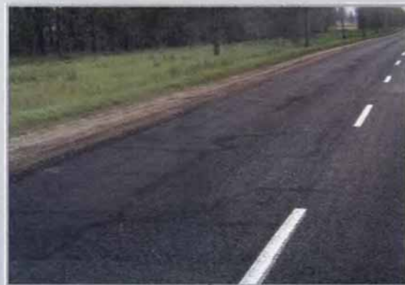
Рис. 6.5. Частые трещины
