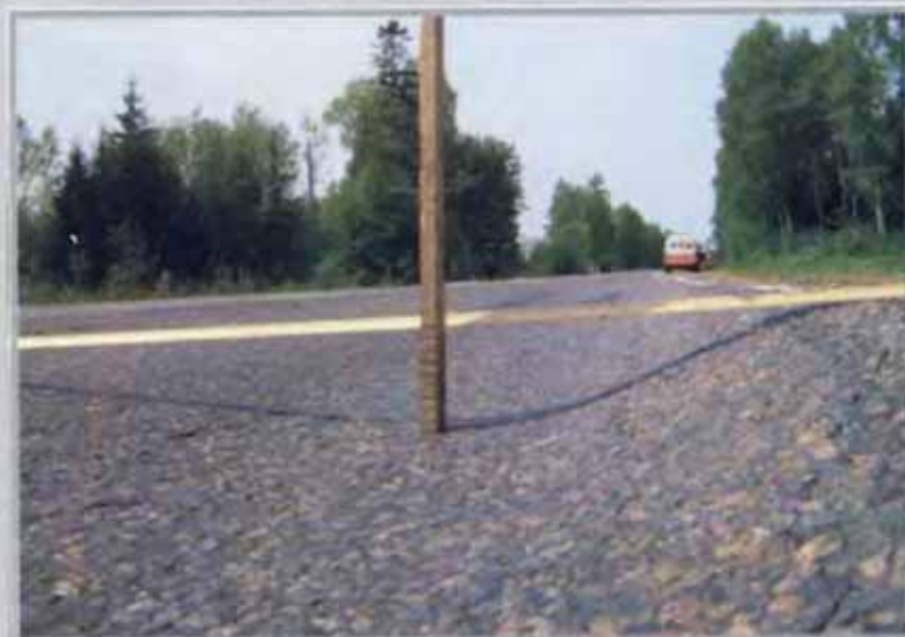
Рис. 6.15. Колейность более 30 мм
