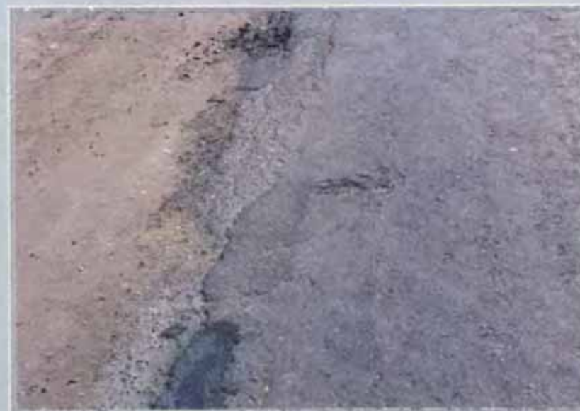
Рис. 6.17. Разрушение кромки
